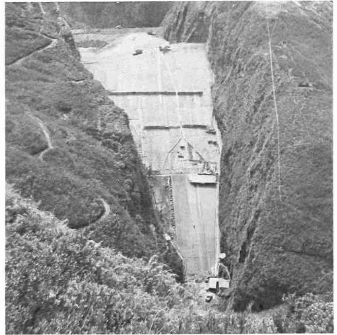
La cortina de la presa "Golillas" vista en su cara aguas arriba, durante los trabajos de revestimiento de concreto. Abajo, uno de los túneles construidos por ICA en el Proyecto Chingaza.
